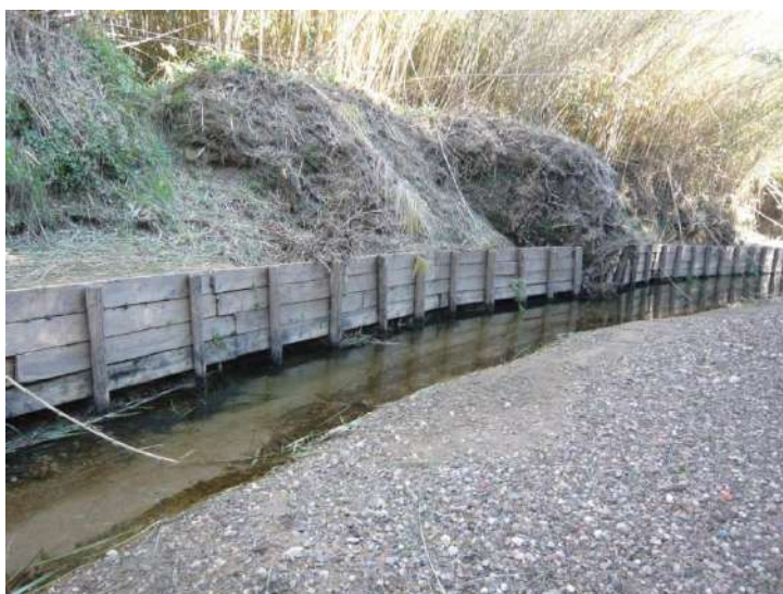
Figure 8 : Illustration de l'inadéquation de la forme du cours d'eau qui ponctuellement engendre des dégâts sur certains aménagement mal conçus (ou pas assez foncés). Ici, il s'agit d'une incision ponctuelle liée à l'inadéquation de la forme du lit, sans pour autant être le signe d'une incision généralisée du lit. On notera, au-dessus du tunage, le mauvais état de la berge et du merlon qui la surplombe.
