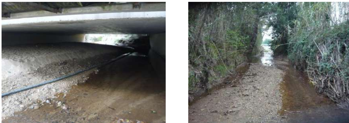
Figure 51 : Présentation des classes de qualité physique sur le Béliou (en % du linéaire parcouru) et illustration : a et b = fort ensablement du linéaire, c = profil en « U », ensablement, aménagements très développés, écoulements uniformes et faible lame d'eau
