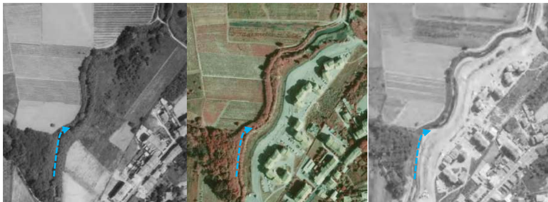
Figure 33 : Illustration des types de travaux : à gauche, 1978 – au centre 1982 - à droite, 1984 : les images sont à la même échelle. Ici, en aval du pont de la RD558 : recalibrage, élargissement du lit mineur, curage des atterrissements, création de formes sont plus « hydrauliques », mise en place d'enrochements et création de merlons sur les rive, maintien de rares arbres. On notera aussi la construction des bâtiments sur un remblai important
