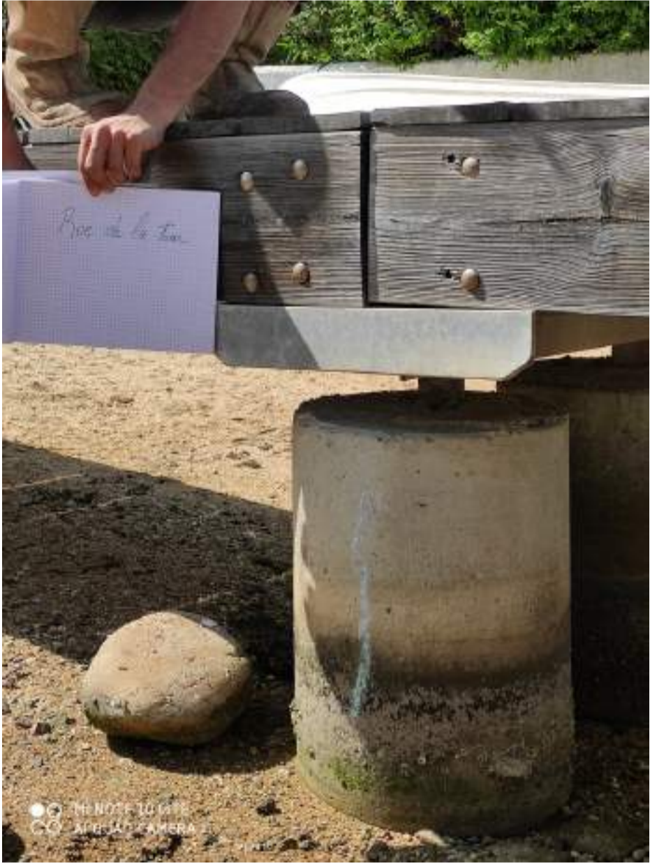
APPUI SUR PIEUX BETON
